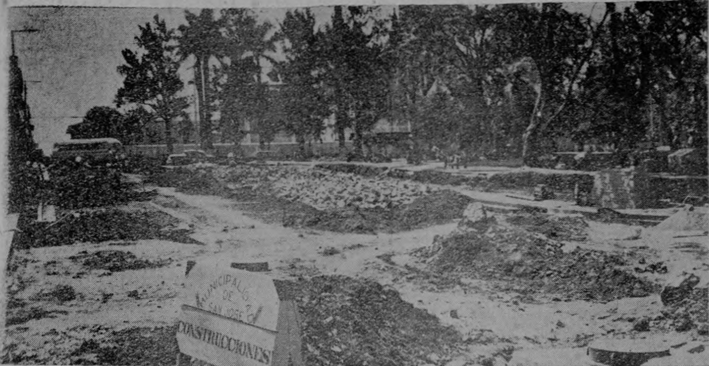
Artavia captó una vista paño-rámica de los trabajos de ampliación de la Avenida Segunda que se vienen realizando en el Parque Carrillo.
